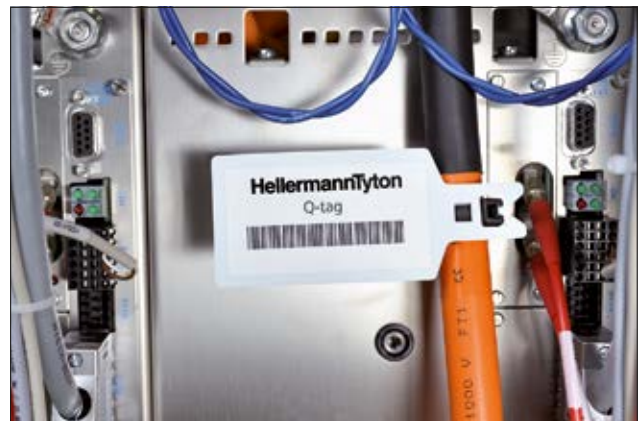
L'orientation des plaquettes Q-tags assure une parfaite visibilité des textes imprimés.
