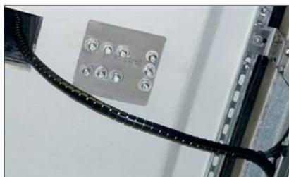
**Helawrap** est une solution qui permet d'accélérer la mise en faisceau de fils et câbles vers les stations météorologiques, les systèmes d'entraînement et dans la porte des armoires d'équipement. Grâce à son profil flexible, Helawrap est facile à installer, même avec des segments préassemblés.
