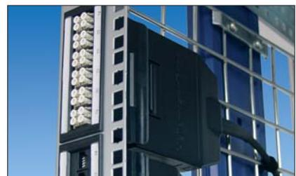
**RapidNet** est une solution innovante qui permet d'optimiser les temps d'installation dans les centres de contrôle des parcs éoliens. Doté des technologies les plus récentes en matière de câbles de cuivre, le système modulaire et enfichable se compose aussi de connexions point-à-point en fibre de verre pré-connectées.
