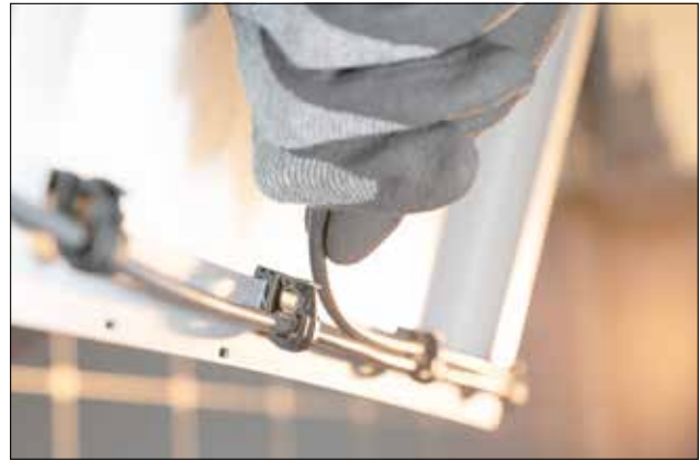
Routage parallèle de 2 câbles sur panneaux photovoltaïques avec EC1-3SPDHC6-7.
