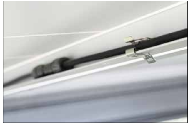
MSC2LP permettent de maintenir les câbles photovoltaïques, là où les fixations en plastique ne sont pas privilégiées.
