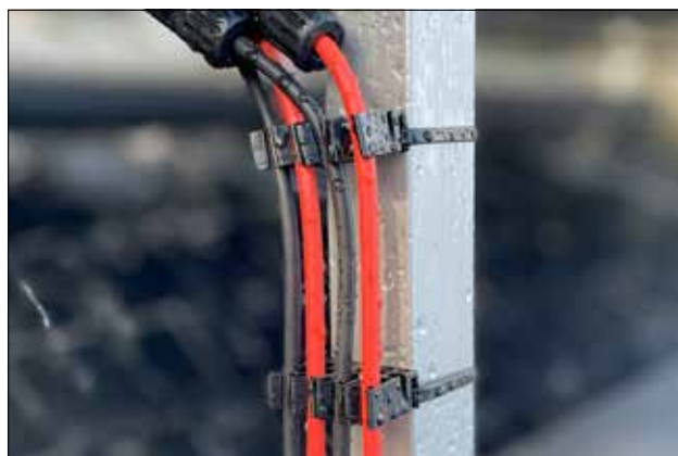
QwicGrip, solution innovante de fixation des câbles sur les structures des panneaux solaires.
